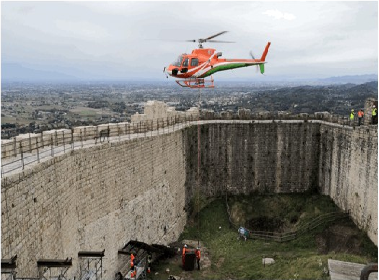
Collocazione con elicottero e montaggio della nuova scala metallica della Rocca medievale di Asolo (TV)
